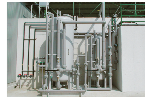
● 砂ろ過・活性炭塔
