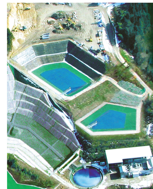
● 水処理プラント・調整池(1号・2号・3号)
